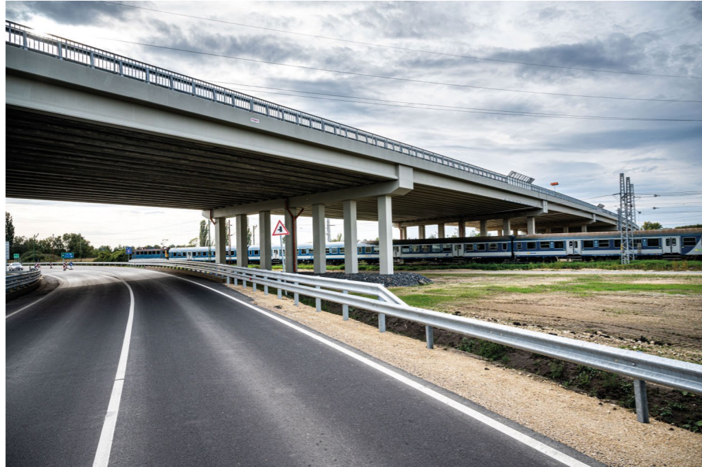
M76 gyorsforgalmi út Balatonszentgyörgy M7 közötti szakasz
