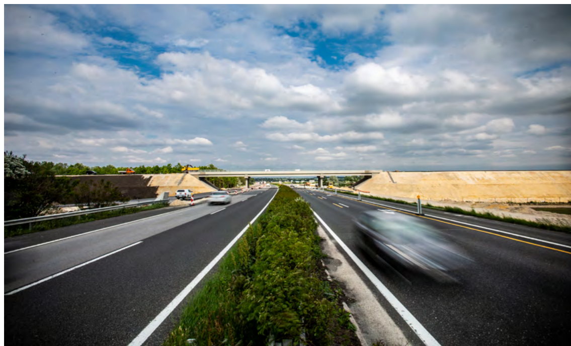
Az M70-es gyorsforgalmi út Letenye és Tornyiszentmiklós közötti szakasza
