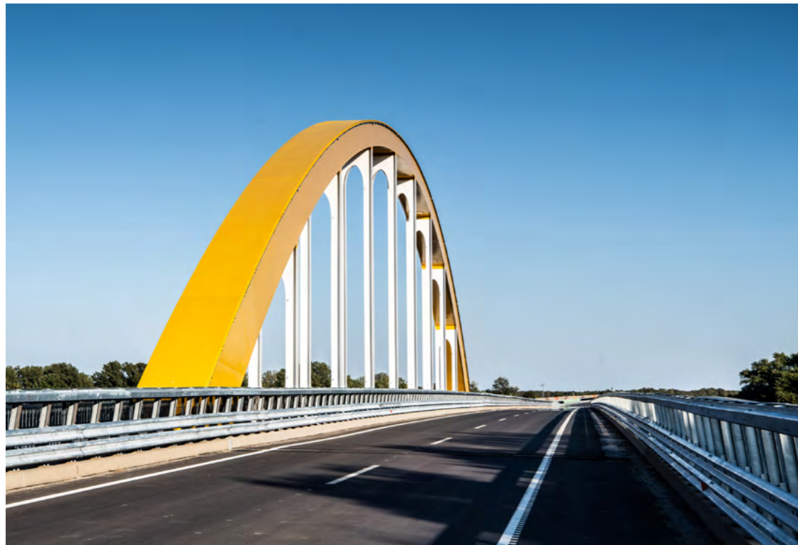
Az M44-es gyorsforgalmi út Tiszakürt és Kondoros közötti szakasza
