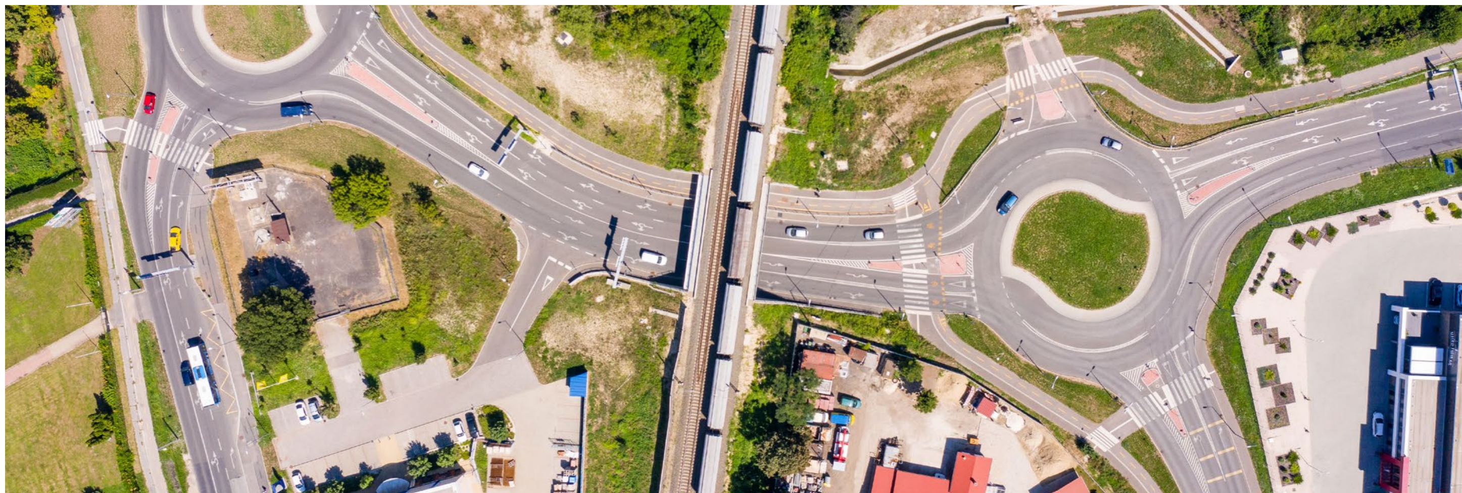
Kelenföld-Százhalombatta vasútvonal felújítás, NIF Zrt.
