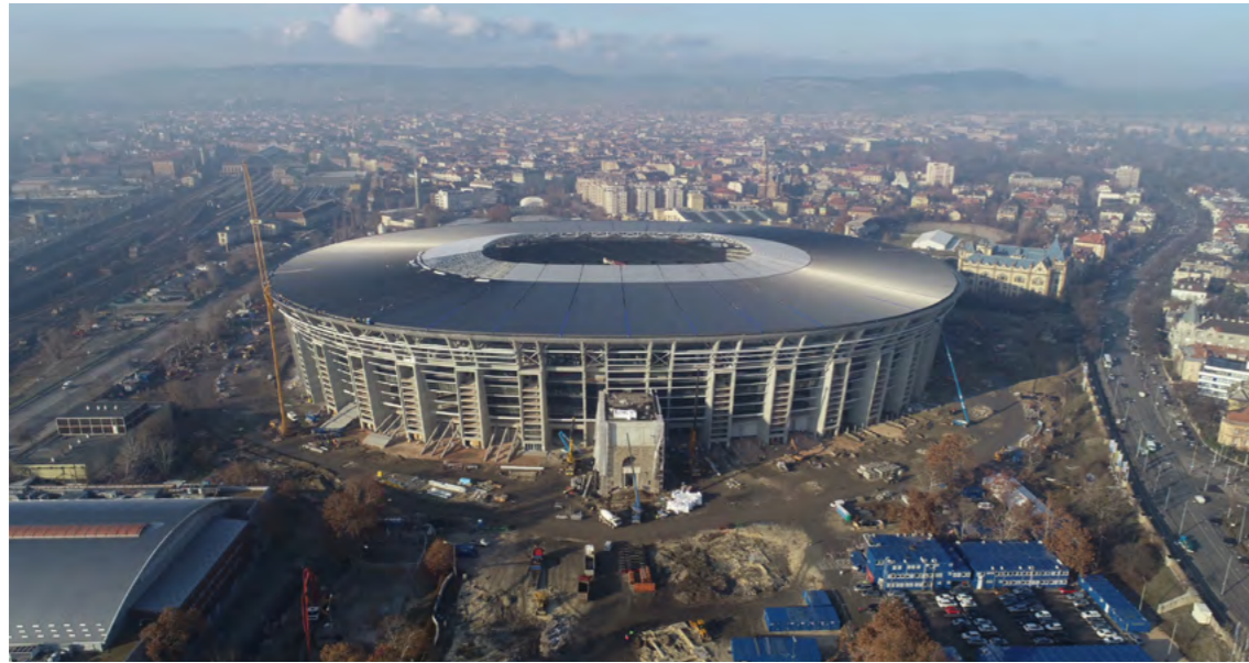
Az épülő Puskás Ferenc Stadion, Budapest
