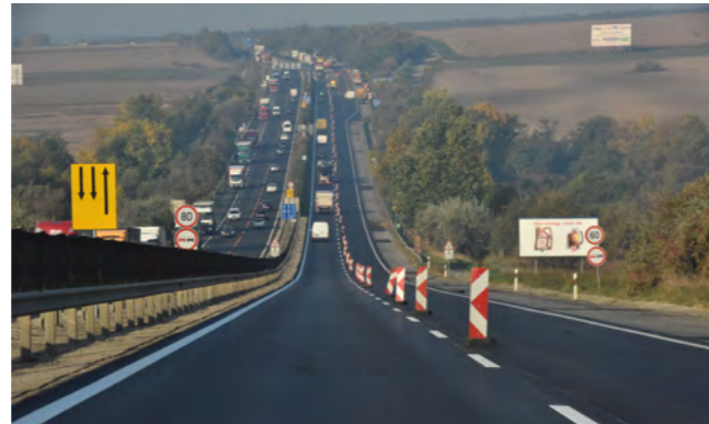
M1-es autópálya útfelújítás
