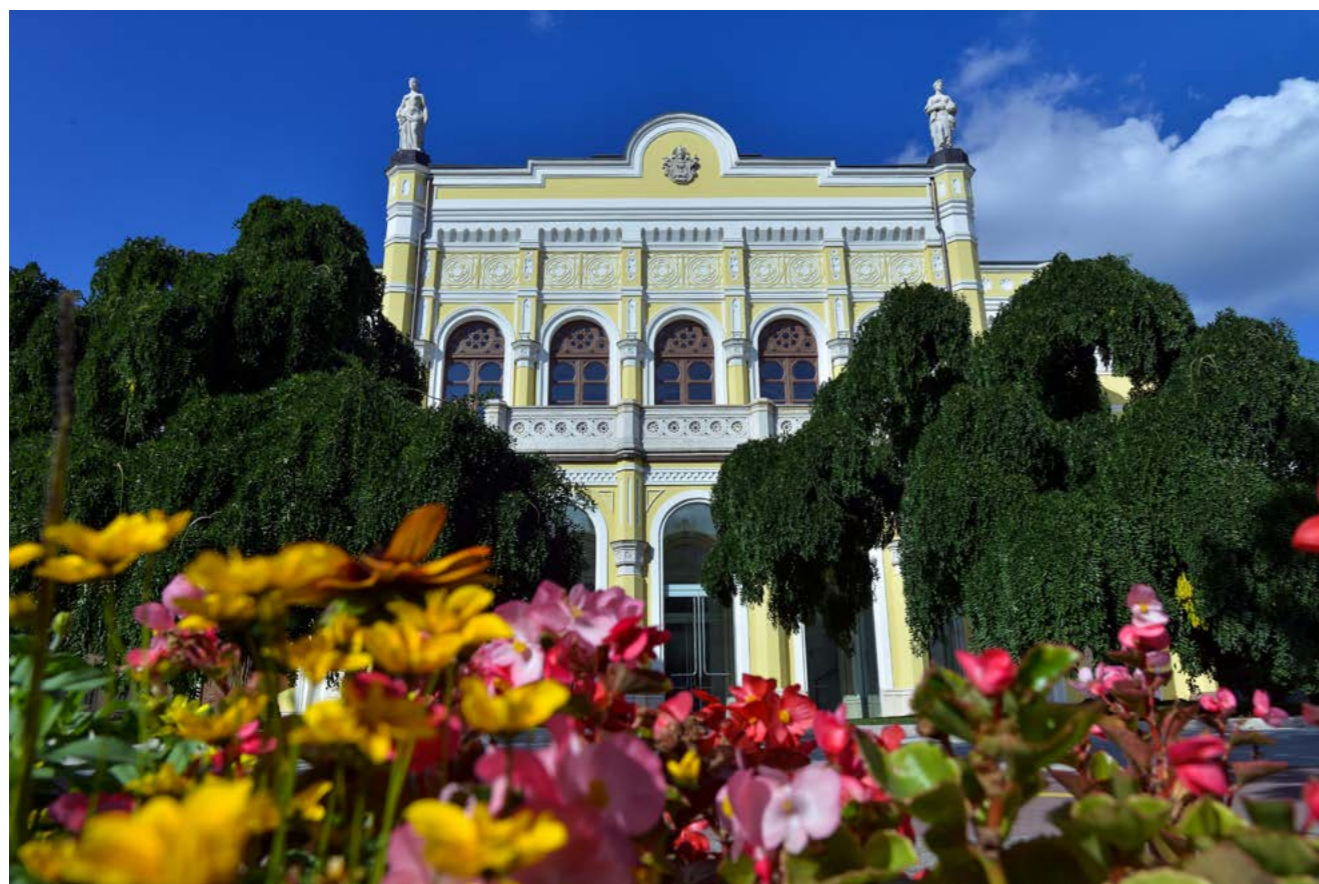
A debreceni Csokonai Nemzeti Színház épülete - 2023-ban Debrecen Megyei Jogú Város pályázata nyerte el építési beruházás kategóriában a Közbeszerzési Hatóság Nívódíját
